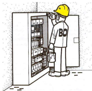
Travaux de peinture au voisinage de pièces nues sous tension du domaine BTA
